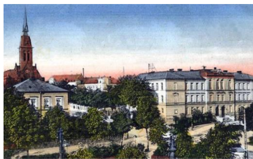
Am Gablenzplatz mit Kirche und Parkanlage ca. 1920
